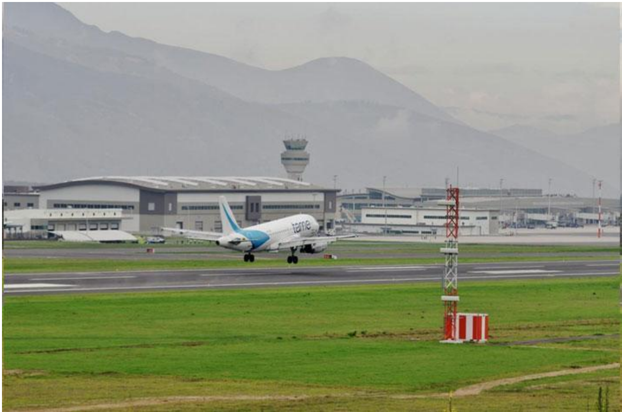
Figure 01: General photo of project / Source: El Nuevo Aeropuerto – Foto reportaje por Chris Chalk; September 2013
