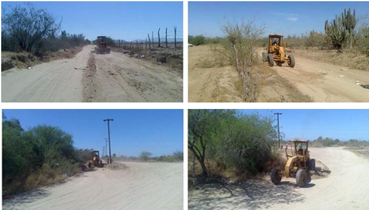
Figure 06: Rehabilitation of two 2 km streets with access to Villas de la Paz. / Source: Martifer Solar. Plan de Consulta y Relaciones Comunitarias, Proyecto Aura Solar I. p. 18.
