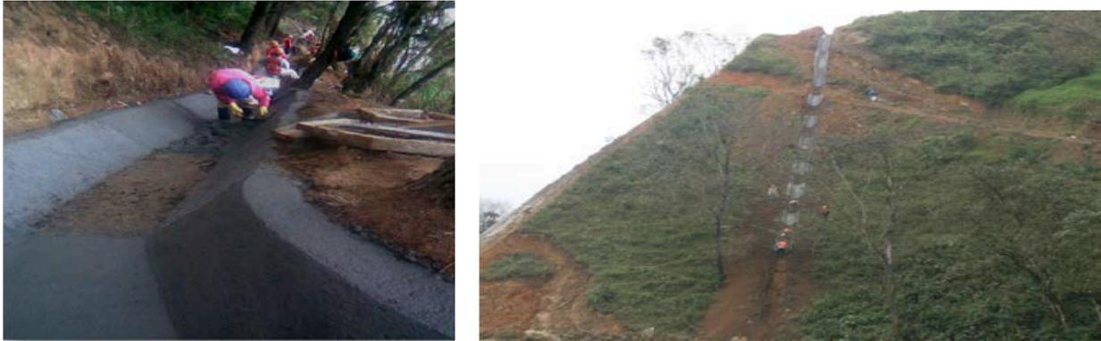
Figuras 33 y 34: Se implementaron sistemas de drenaje para controlar la escorrentía y preservar el sistema hidrológico.
