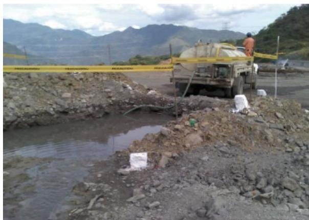
Figuras 27 y 28: Excavación de áreas de captación de agua para almacenar escorrentía o aguas superficiales para su uso posterior en la etapa de construcción.
