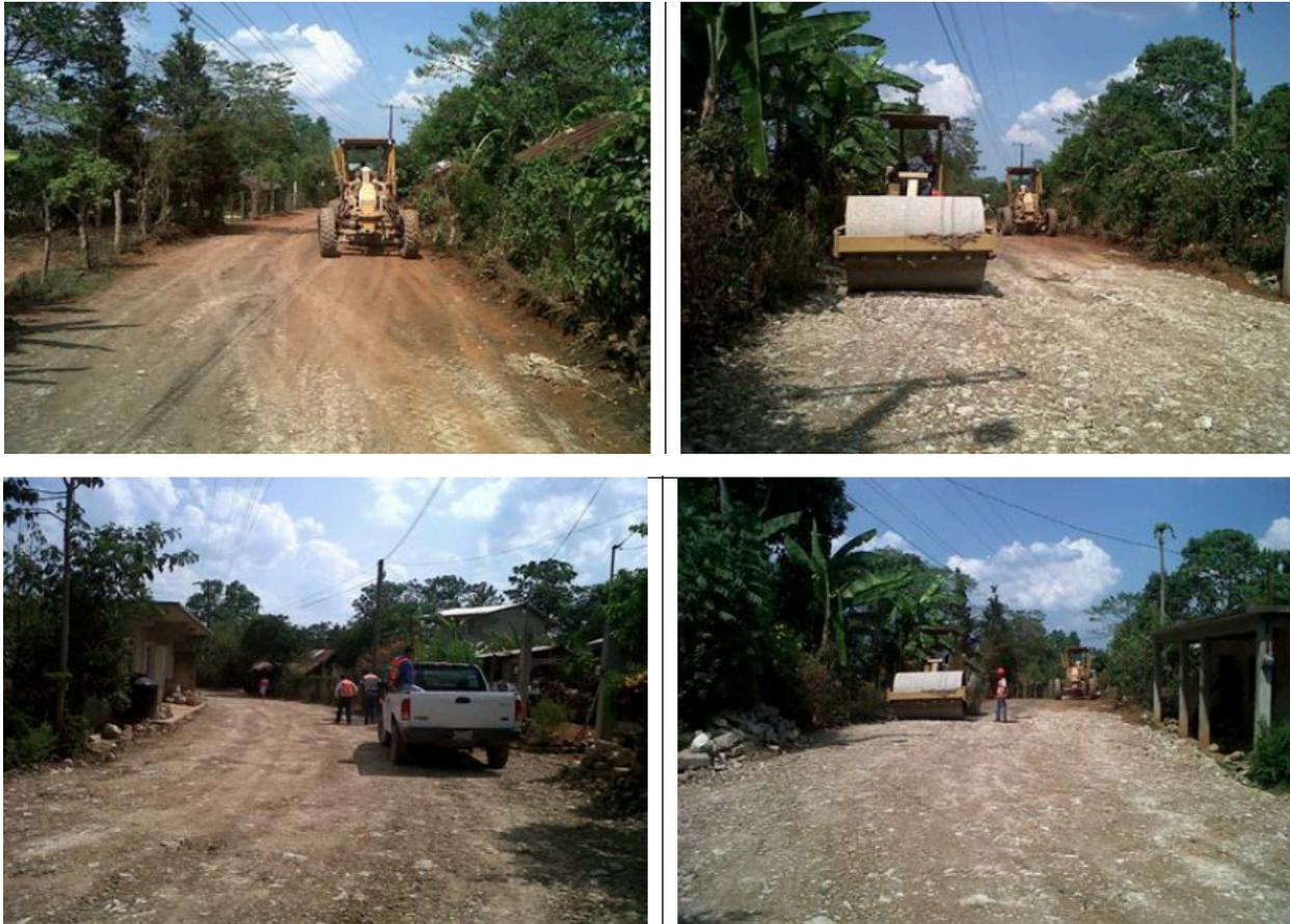
Figuras 07-10: Rehabilitación de la vía de acceso a la comunidad de Plan de Ayala utilizada inicialmente por el proyecto.
