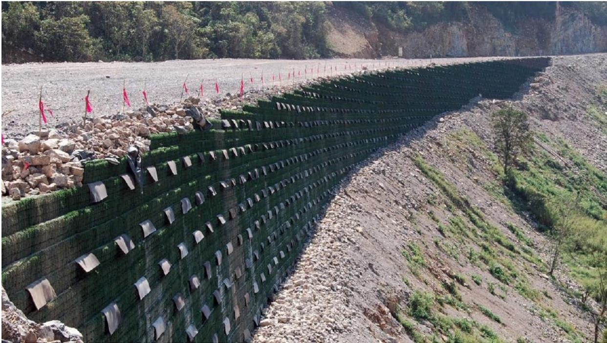
Figura 19: Muro reforzado con materiales geosintéticos.
