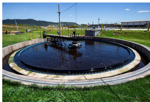
Figure 14: Treatment of the leachate. Sources: Cidade Olímpica. CTR Seropédica . Accessed in 2015. http://www.cidadeolimpica.com.br/academia-da-terceira-idade-2/
