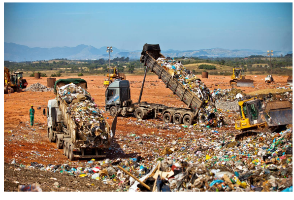
Figure 11: Dumping the waste on site. Sources: Cidade Olímpica. CTR Seropédica . Accessed in 2015. http://www.cidadeolimpica.com.br/academia-da-terceira-idade-2/
