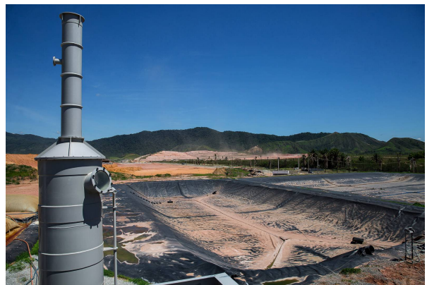
Figure 13: Leachate covered.. Sources: Cidade Olímpica. CTR Seropédica . Accessed in 2015. http://www.cidadeolimpica.com.br/academia-da-terceira-idade-2/
