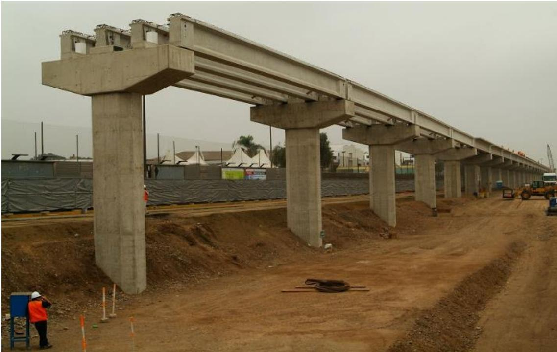
Figura 74: Superestructura prefabricada L1ML
