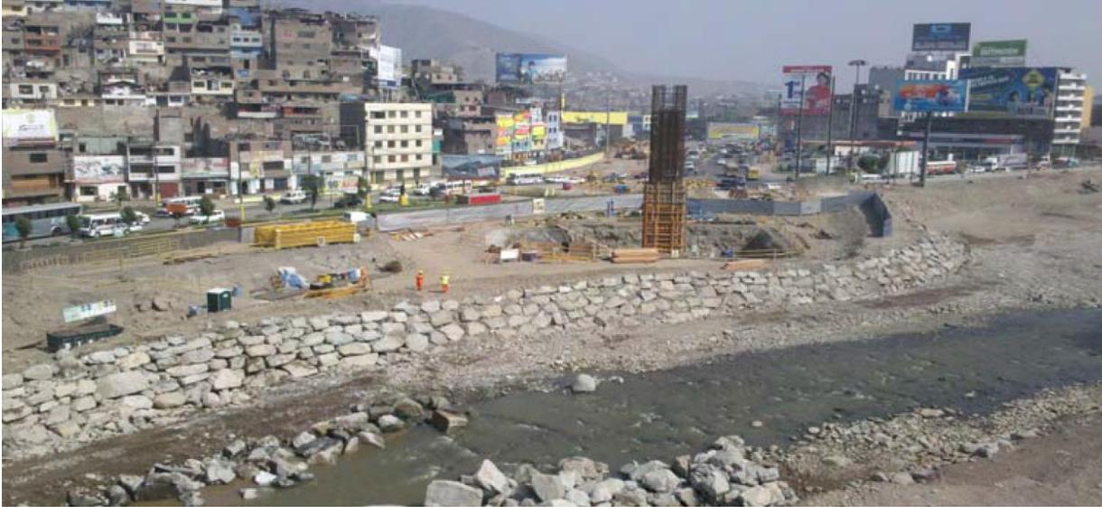
Figura 76: Diques protectores en el Río Rímac durante la construcción de la L1ML / Fuente: MTC and Consorcio Tren Eléctrico, Memoria Descriptiva de las Obras Provisionales en el Lecho del Río Rímac, p. 8.
