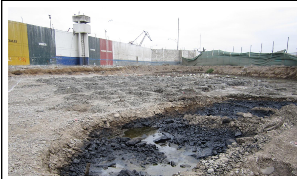
Figura 12: Proceso de remediación de tierras Fuente: APM Terminales Callao
