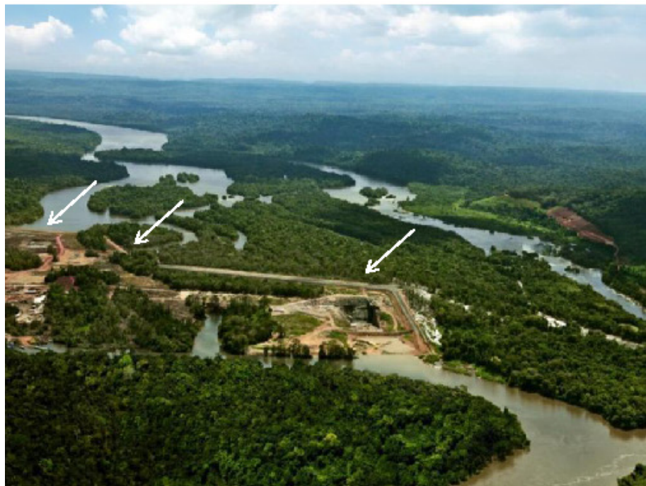
Figura 30: Planta hidroeléctrica del Jari: secuencia de la construcción 2 Fuente: Aproveitamento Hidrelétrico Santo Antônio do Jari, p. 19.
