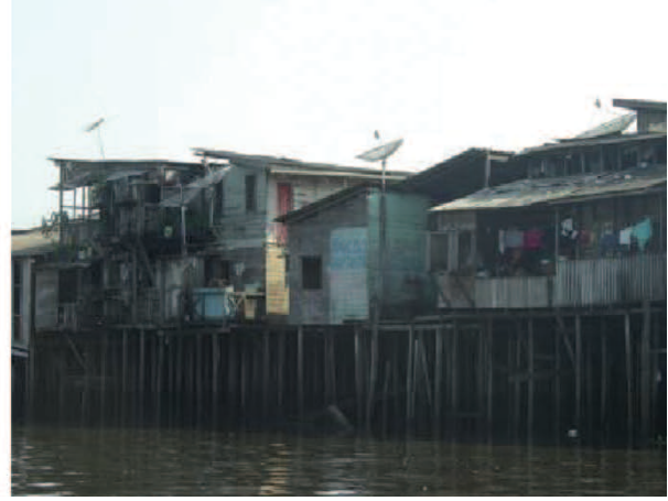
Figura 07: Viviendas construidas sobre pilotes en Laranjal do Jari Fuente: Relatório de Impacto Ambiental (RIMA) , creado por Ecology Brazil, p. 33.
