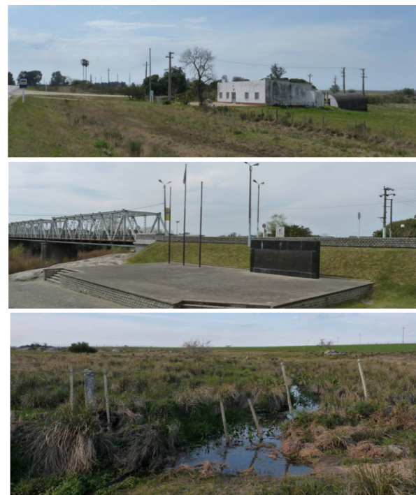
Figure 7: The surrounding infrastructure, roads and waterways. Sources: CSI Ingenieros, "Parque Eólico Estudio de Impacto Ambiental (EIA)." Octubre 2010, p.34, p.34, p.21
