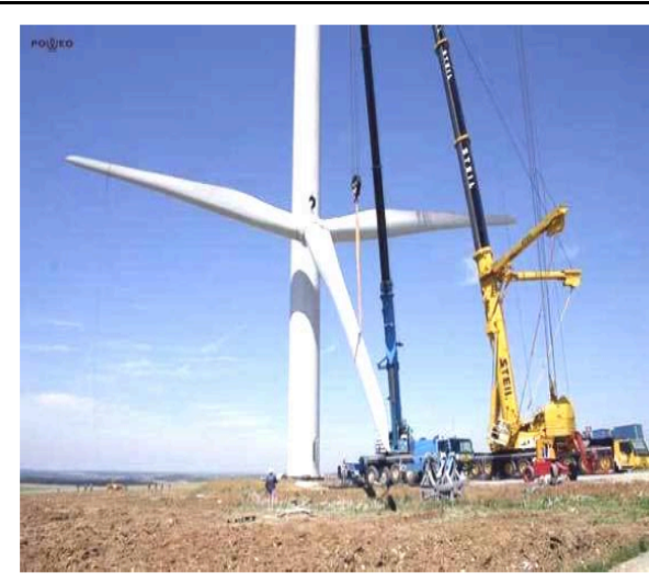
Figure 17: Putting the turbines together on the site. Sources: Piñon, A, Polesine S.A., "Componente Nacional de Inversión Parque Eólico Florida."
