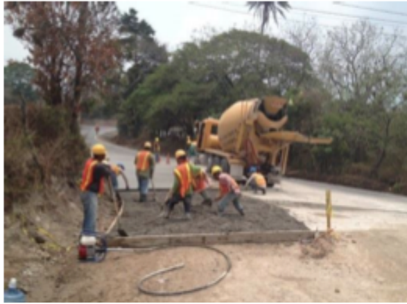
Figure 17: Construction of an intersection. Source: EEHSA, Informe de Cumplimiento de Medidas Ambientales ICMA, p. 16
