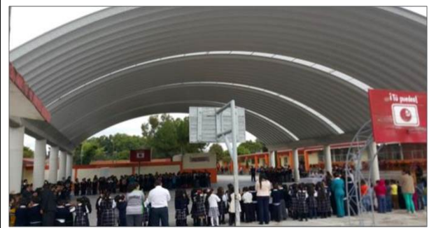
Figura 21: Los niños/as de la escuela están en su nuevo teatro cívico con el techo instalado por EGP.
