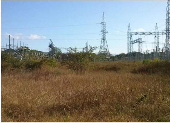
Figura 27: Condiciones iniciales de campo antes del desarrollo. Fuentes: Cobra, Reporte Fotográfico: Proyecto Ampliación de la Sub Estación Santa Lucía 230 kv y 34.5 kv (2015), 2.
