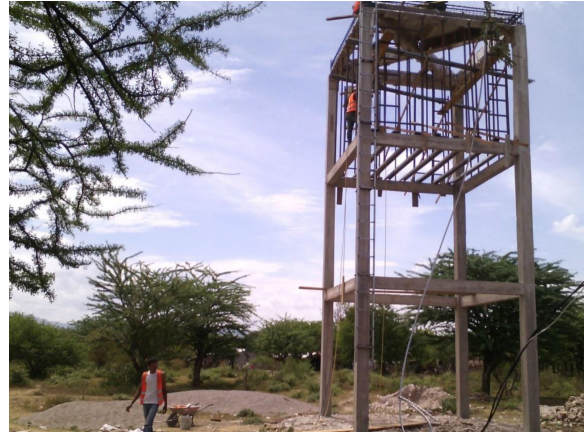
Figura 11: Construcción de un tanque elevado para distribuir agua a la comunidad por medio de la gravedad en Colonia Victor Manuel Argeñal I. Fuentes: Clever Honduras, Informe de Avance Social de Sitio Pacífico I, Choluteca I y II . Semana del 06 al 12 de agosto del 2015 (Choluteca, 2015), 5.
