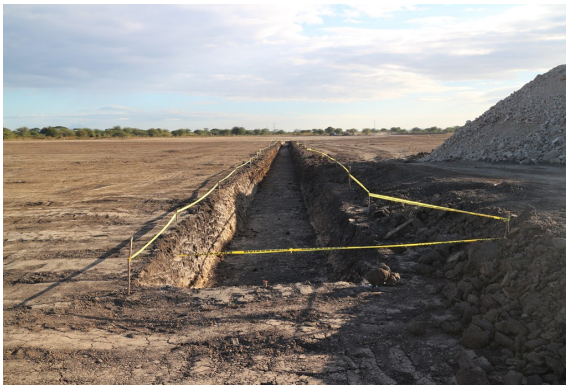
Figura 31: Excavación del sistema de desagüe durante la fase de construcción. Fuentes: Anexo Fotográfico .
