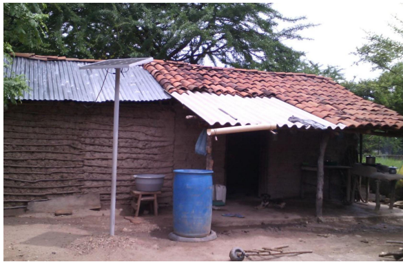
Figura 12: Instalación de paneles solares en la Aldea Montecillos. Fuentes: Clever Honduras, Informe de Avance Social de Sitio Pacífico I, Choluteca I y II . Semana del 16 al 22 de julio del 2015 (Choluteca, 2015), 15.
