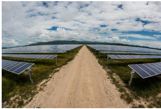
Figura 32: Plano de los módulos fotovoltaicos. Fuentes: Anexo Fotográfico .
