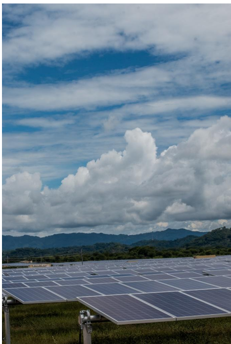
Figura 35: Plano de los módulos fotovoltaicos. Fuentes: Anexo Fotográfico.
