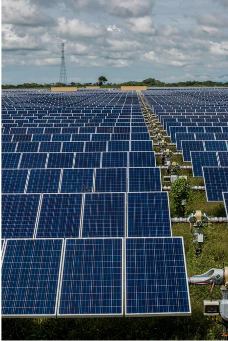
Figura 33: Plano de los módulos fotovoltaicos. Fuentes: Anexo Fotográfico.
