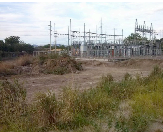
Figure 29: Ground Conditions on January 05, 2015. Sources: Cobra, Reporte Fotográfico: Proyecto Ampliación de la Sub Estación Santa Lucía 230 kv y 34.5 kv (2015), 3.
