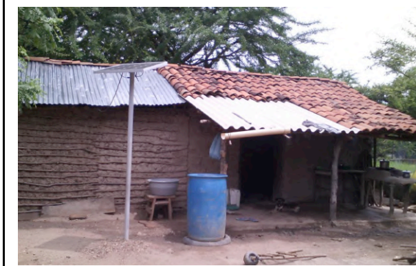
Figure 12: Installation of solar panels for Aldea Montesillos. Sources: Clever Honduras, Informe de Avance Social de Sitio Pacífico I, Choluteca I y II . Semana del 16 al 22 de julio del 2015 (Choluteca, 2015), 15.
