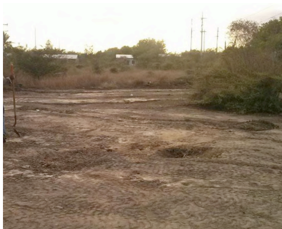
Figure 30: Ground Conditions on January 05, 2015. Sources: Cobra, Reporte Fotográfico: Proyecto Ampliación de la Sub Estación Santa Lucía 230 kv y 34.5 kv (2015), 3.
