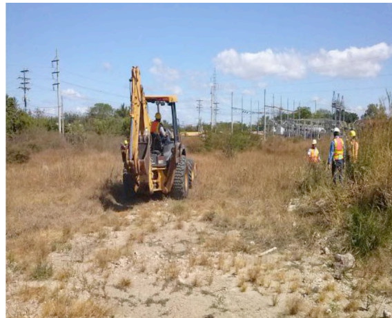
Figure 28: Removal of Topsoil and Relocation of Fauna. Sources: Cobra, Reporte Fotográfico: Proyecto Ampliación de la Sub Estación Santa Lucía 230 kv y 34.5 kv (2015), 2.
