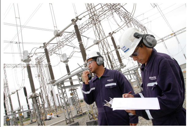
Figura 12: Trabajo dentro de la planta. Fuente: EnerSur.
