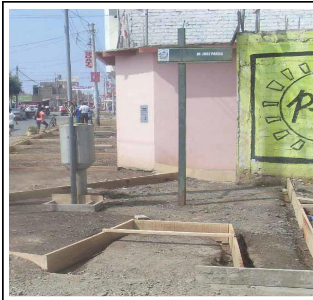
Figura 19: Construyendo aceras en la comunidad de Chilca. Fuente: EnerSur, Suplemento Chilcano Mayo 2012 (Peru: EnerSur, 2012), 5.
