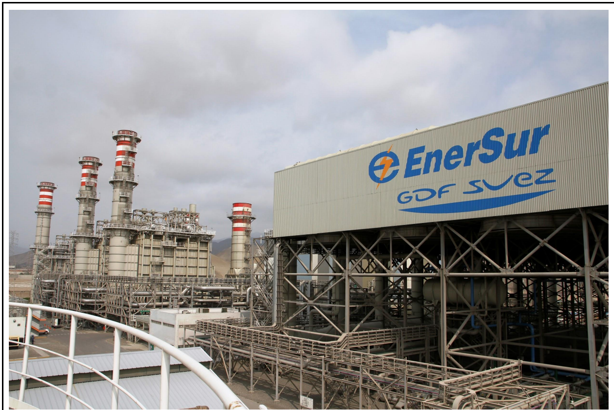
Figura 05: Vista general del proyecto. Fuente: EnerSur.
