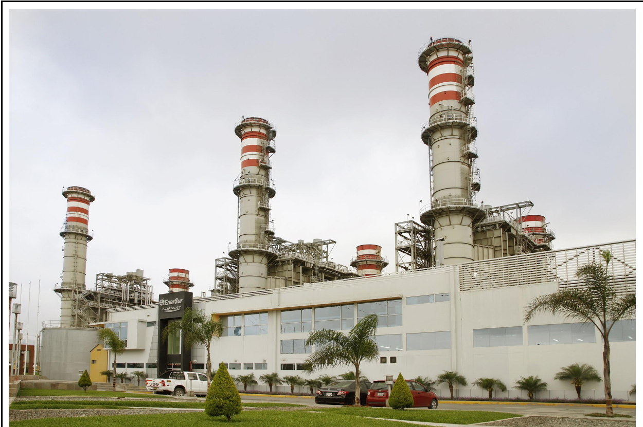
Figura 01: Vista general del proyecto. Fuente: EnerSur.
