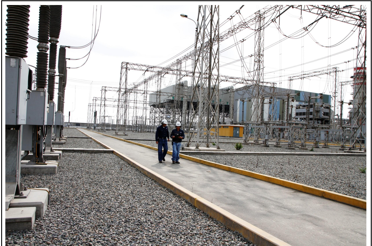
Figura 06: Vista general del proyecto. Fuente: EnerSur.
