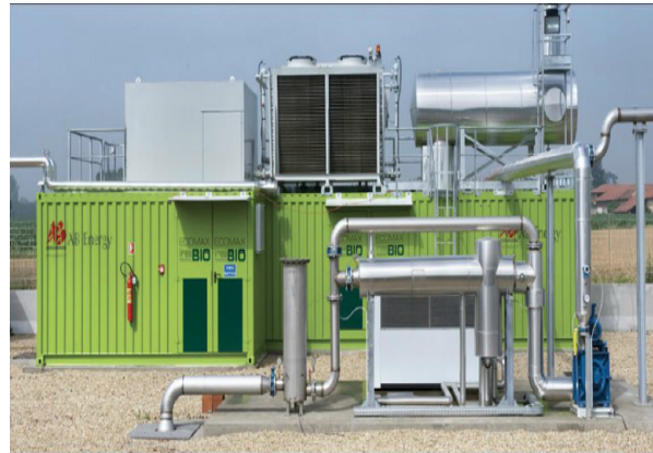
Figure 10: Biogas capture from the CTR Caieiras landfill. Sources: Solvi Valorização Energética.
