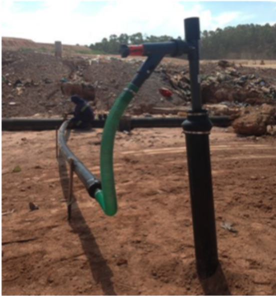
Figure 10: Biogas capture from the CTR Caieiras landfill. Sources: Solvi Valorização Energética.
