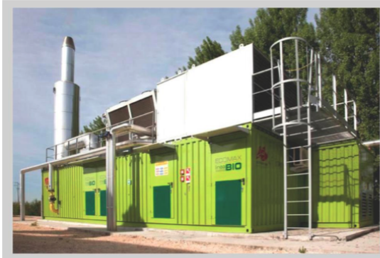
Figure 11: Biogas Treatment System Unit. Sources: Solvi Valorização Energética.
