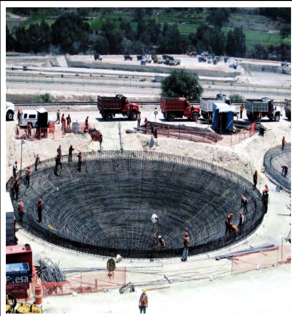
Figura 15: Foto de las obras de construcción. Fuentes: SEMARNAT. Planta de Tratamiento de Aguas Residuales Atotonilco . México: 2014.
