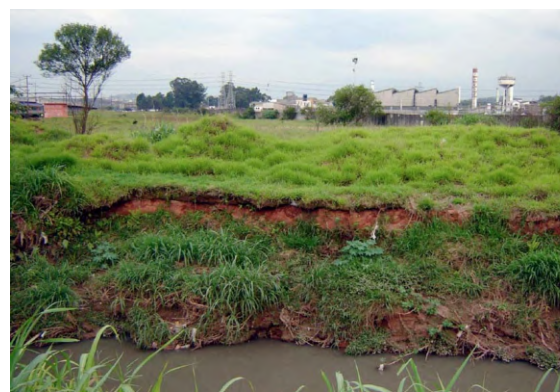
Figure 42: Embankments in the pipeline path in Santo André. Sources: CH2MHILL - ALPHAPLAN, Relatório Ambiental Preliminar do Sistema de Adução de Efluentes Tratados para o Pólo Petroquímico de Capuava (February, 2012).
