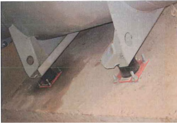
Figure 33: Noise and vibration adjustments. Sources: Aquapolo Ambiental S.A., Laudo técnico de Avaliação de Vibrações em Áreas habitadas (June 22, 2012).
