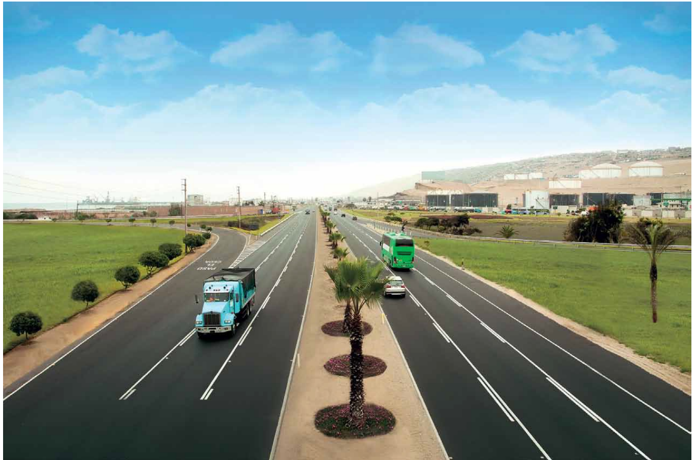
Figure 01: General photo of project. Source: Volante Vías Modernas y seguras, Rutas de Lima
