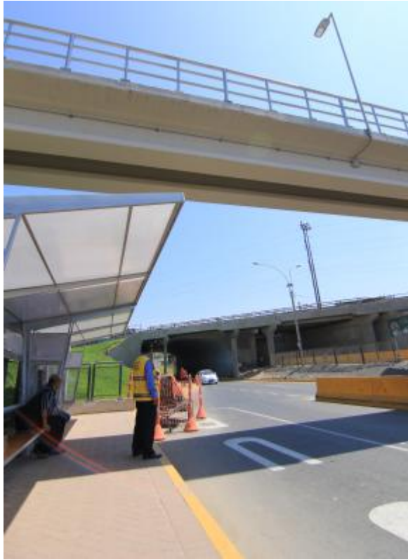
Figura 28 : Vista del Puente peatonal Fuentes: Vías Nuevas de Lima
