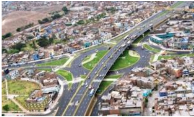
Figura 22: Vista de rotonda y el paso sobre nivel. Fuentes: Vías Nuevas de Lima
