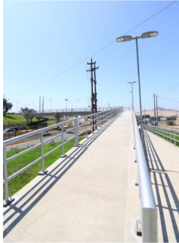
Figura 29 : Vista del Puente peatonal Fuentes: Vías Nuevas de Lima
