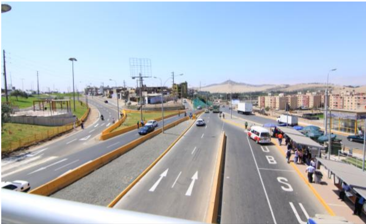
Figura 30 : Vista del Puente peatonal Fuentes: Vías Nuevas de Lima
